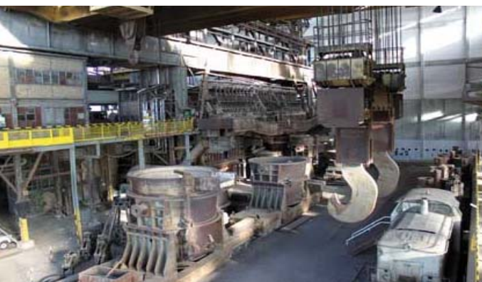
Abb4. Dieselhe Halle wie Abb. 3, diesmal mit Blick nach Osten. Im Vordergrund eine Werkdiesellok.
