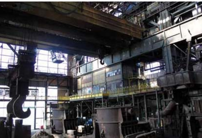
Abb.3 Halle zwischen Gießbühne und Ofenbühne. Links die 200t-, Mitte oben der 50t-Haken. Unten Mitte 200t- und 180t-Pfanne. Blick nach Westen.
