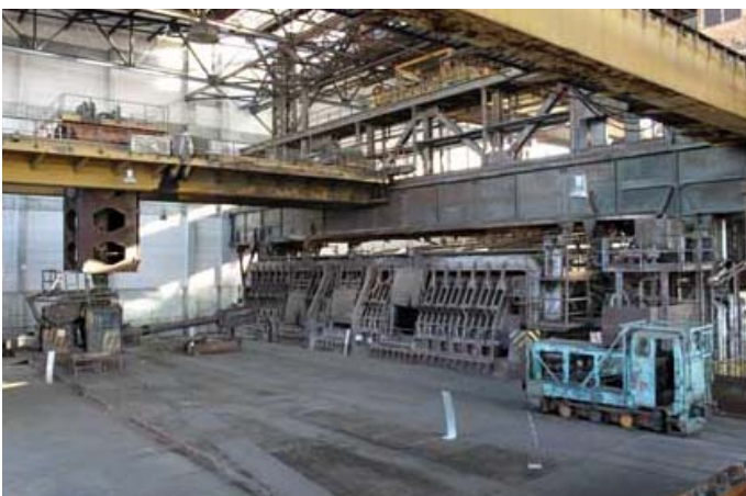
Abb. 8 Die Ofenbühnen mit Chargierkran und geöffneter Ofenluke 3
