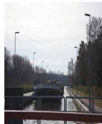
Der Tanker „Da Capo“ im Oberwasser des Ihlekanals an der Zerbener Schleuse
